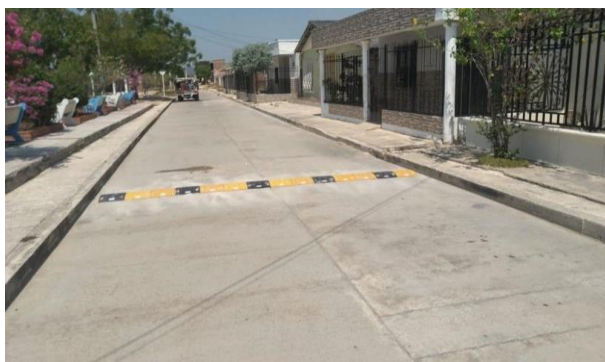
Ilustración 35 Reductores de velocidad
