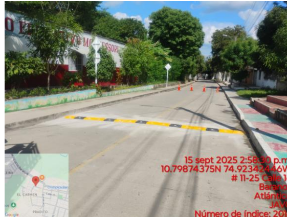
Ilustración 95. Registro fotográfico de instalación de reductores de velocidad en Baranoa
