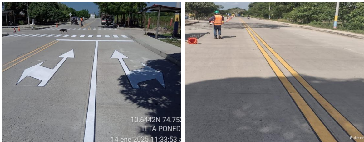
Ilustración 92. Registro fotográfico de demarcación vía Principal Ponedera
