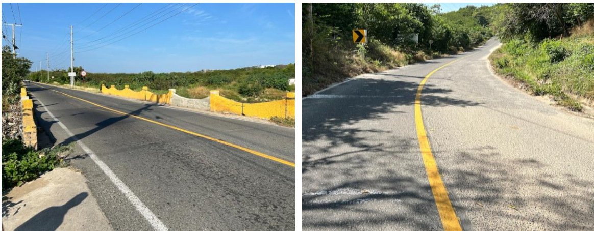
Ilustración 93. Registro fotográfico de demarcación vía Carrera 51B – Sabanilla – Puerto Colombia
