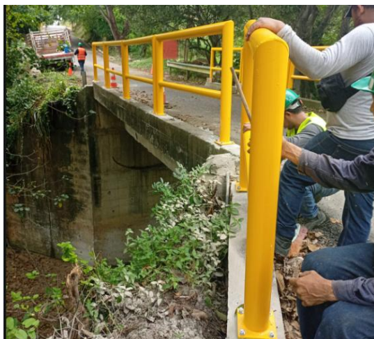
Ilustración 101. Registro fotográfico de la Instalación de horquillas puente Usiacurí.
